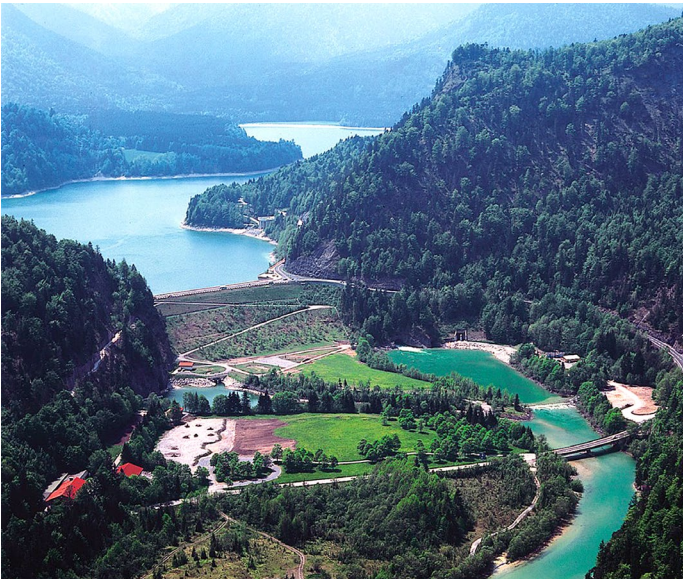
Bild1: Talsperre Sylvensteinspeicher mit einem Rückhaltevolumen von 79 Mio. M 3 , neben Lenggries und Bad Tölz. (Quelle: WWA Weilheim)
